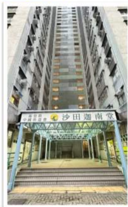
裝修後的天井
